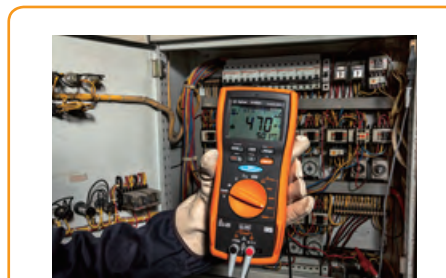
调试电气安装时, 测试绝缘电阻电缆
