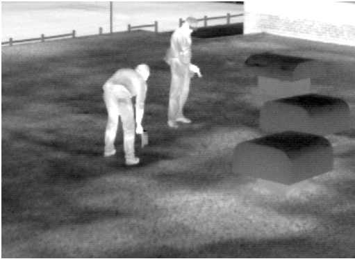
屋顶隔热层检测
