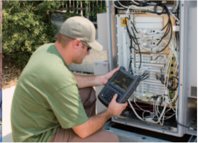
图 1b. FieldFox 直接连接到无线通信系统上的馈线
